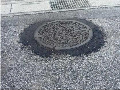
中央7丁目の市道のマンホールの回りの段差解消への応急処置です。
