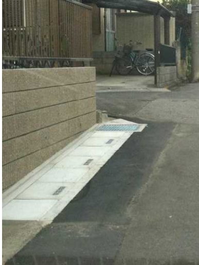
左 緑町3丁目道路側溝の補修を行いました。
